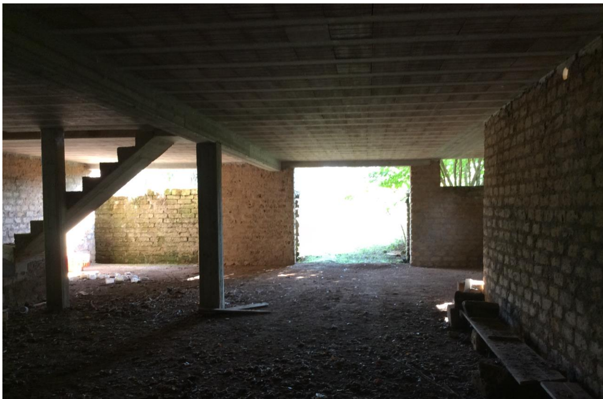
foto 7 – vista area di lavoro capannone
