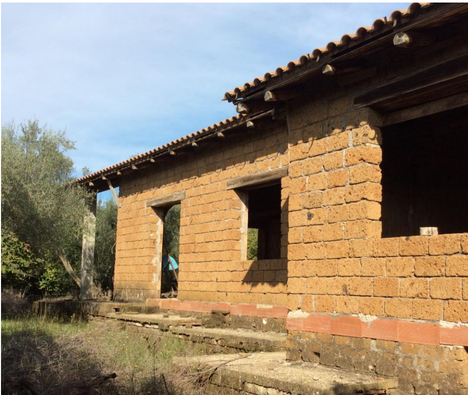
foto 4 – vista prospetto laterale
