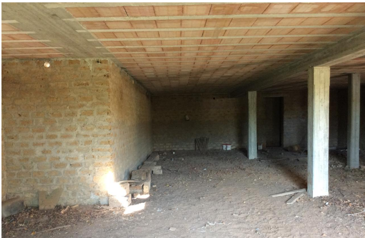
foto 6 – piano seminterrato (rimessa attrezzi agricoli)
