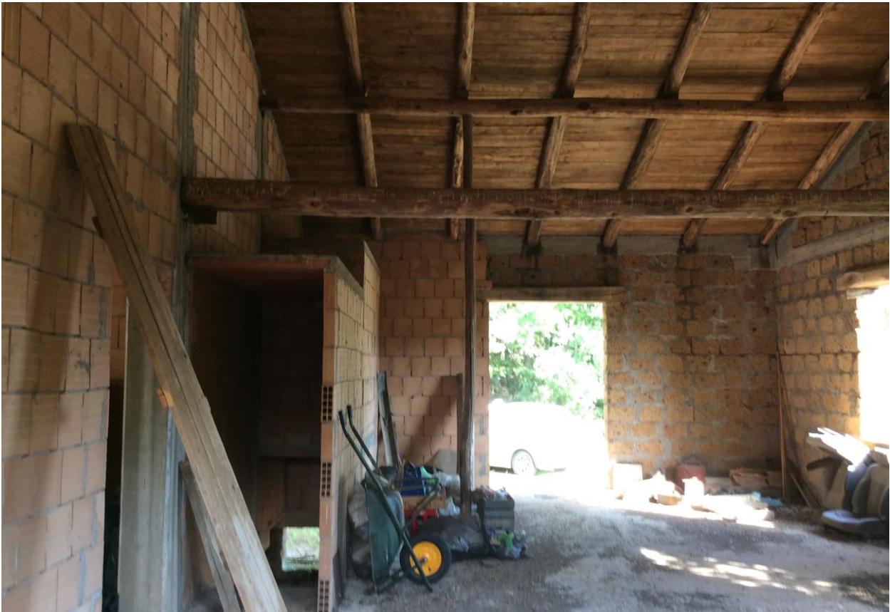
foto 13 – vista tetto (area non residenziale – rimessa attrezzi)
