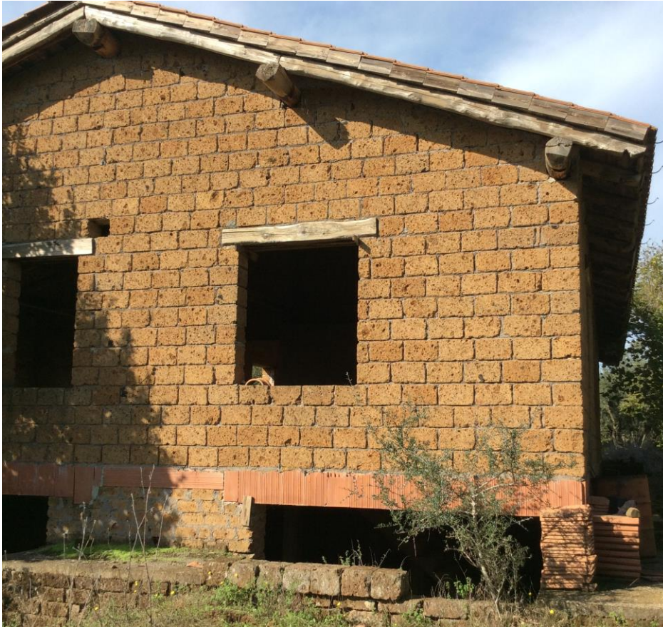
foto 1 – vista facciata principale
