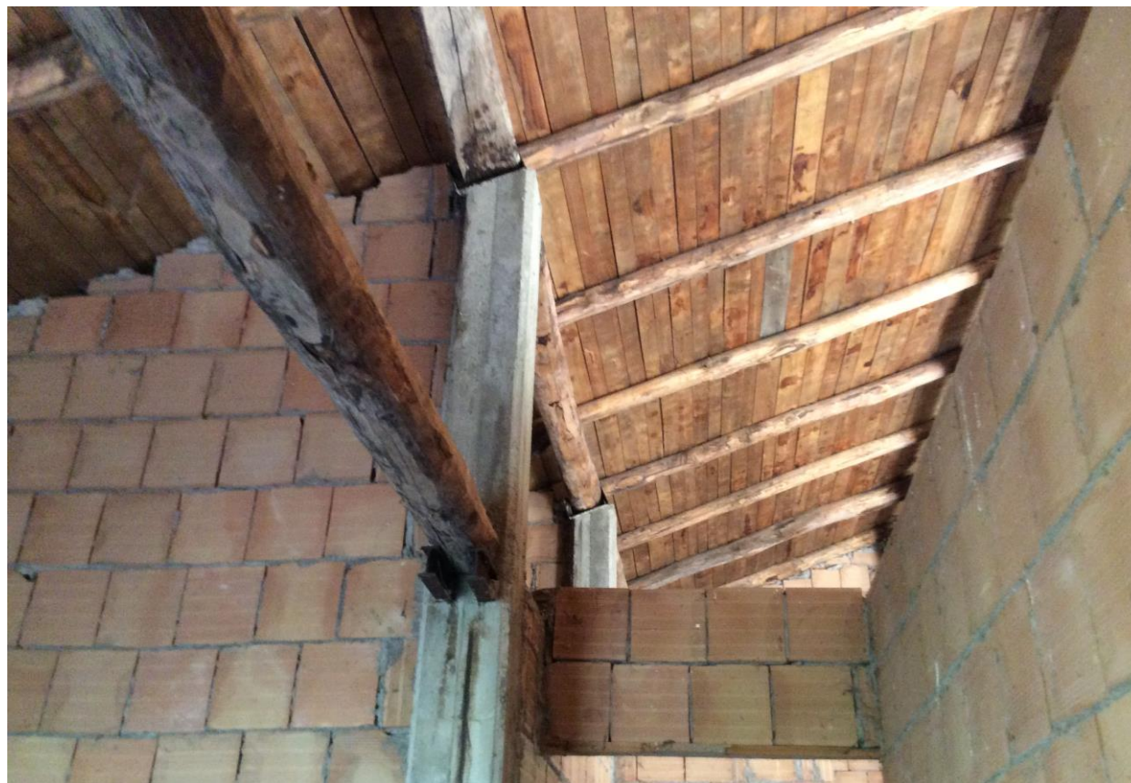
foto 11 – vista tetto (area residenziale)
