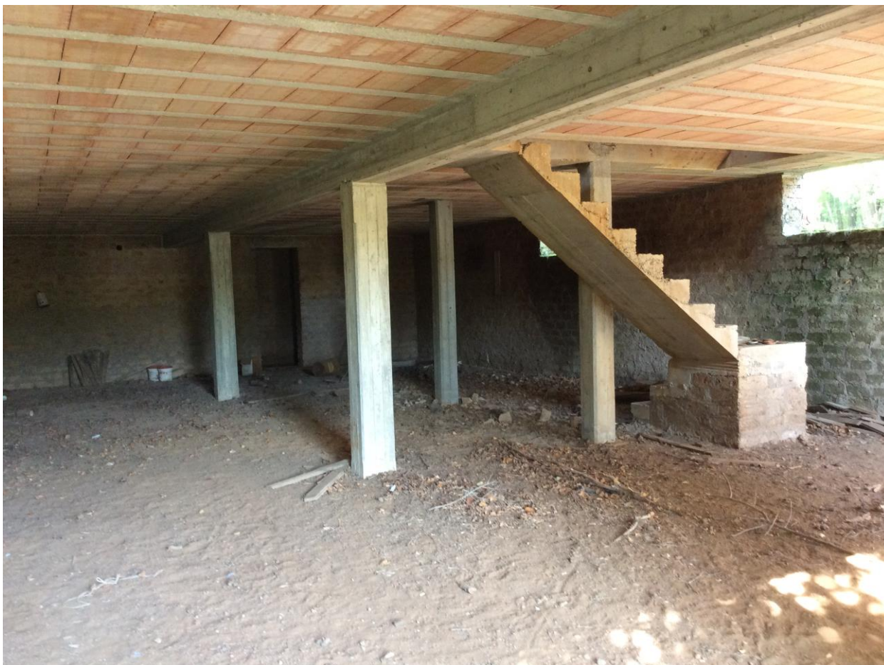
foto 5 – piano seminterrato (rimessa attrezzi agricoli)
