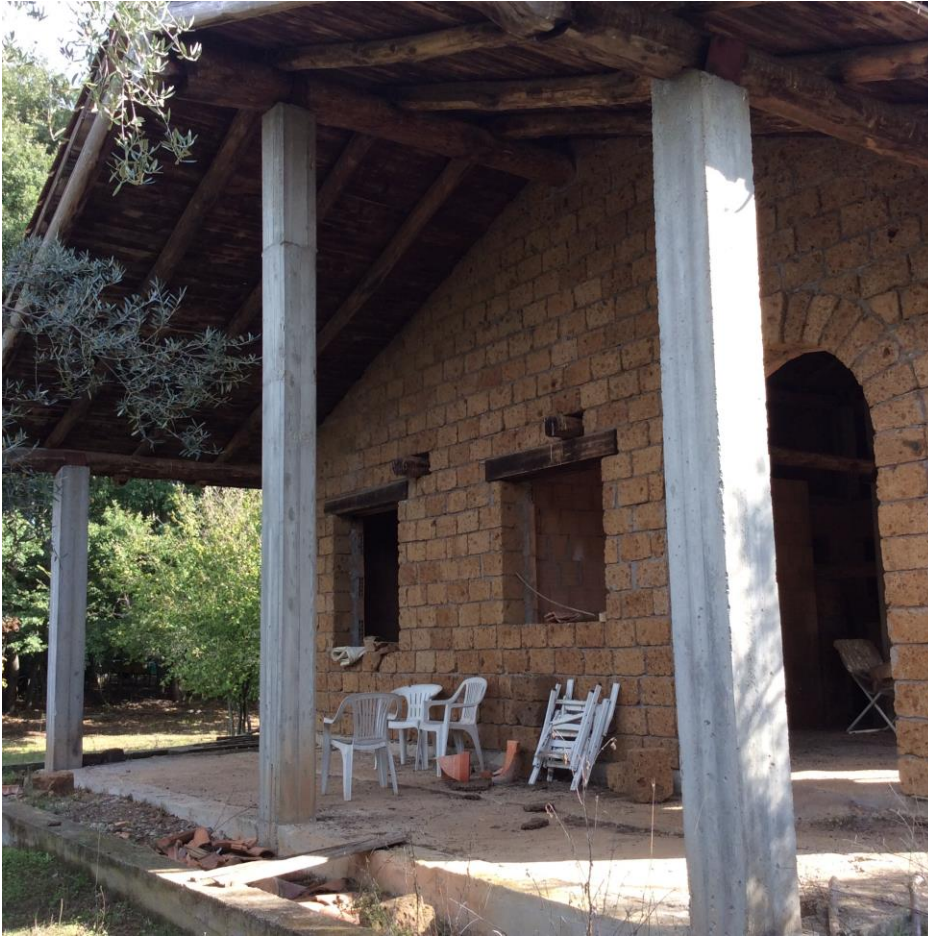
foto 3 – vista prospetto posteriore (portico)
